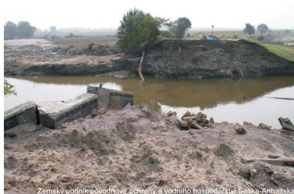
Obr. 3.2-7: Protržená ochranná hráz na obtokovém kanálu Labe
