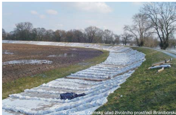
Obr. 3.2-10: Povodeň v dubnu 2006, říční ohyb u obce Rühstädt - hradba z pytlů s pískem na vzdušné straně hráze
