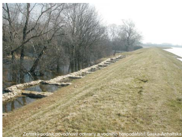
Obr. 4.3-6: Zabezpečovací práce na hrázi Prettin při povodni 2006
