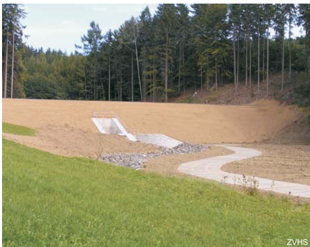
Obr. 2.5-1: Suchá nádrž Čermná II v oblasti povodí Horního a středního Labe
