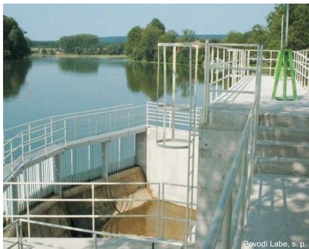
Obr. 3.1-4: Vodní nádrž Hvězda – dokončený bezpečnostní přeliv
