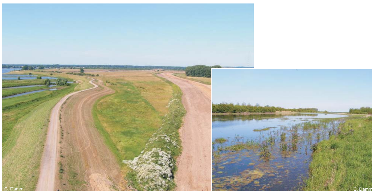
Obr. 2.5-15: Stavební fáze ochranné hráze v detailu a odstavené rameno u obce Lenzen
