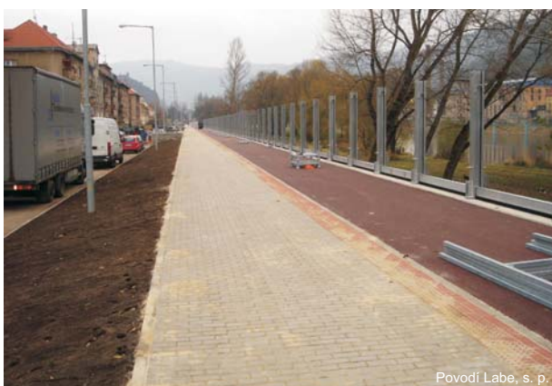
Obr. 3.1-6: Linie hrází s mobilním hrazením v Ústí nad Labem
