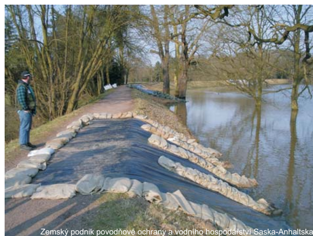
Obr. 4.3-5: Zabezpečení hráze v parku Wörlitz při povodni 2006 – Zahradní říše Dessau-Wörlitz je světovým dědictvím UNESCO
